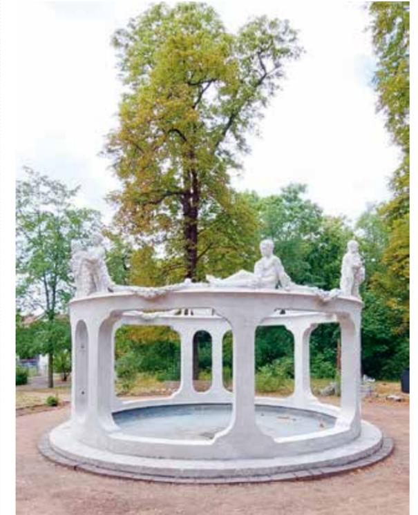
Die Sanierung des Bethcke-Lehmann-Brunnens schreitet voran. Die Restaurierung der Figuren und des Betonkorpus ist abgeschlossen. Als nächstes werden die Gitter detailgetreu in einer Schmiede nachgefertigt. Am Ende stehen die Wiederherstellung der Dichtigkeit des Beckens und die Planung und Installation der gesamten Springbrunnentechnik. Die Sanierung wurde ermöglicht durch eine großzügige Privatspende, sowie Förderungen der Deutschen Stiftung Denkmalschutz und von Lotto-Toto, Sachsen-Anhalt..
